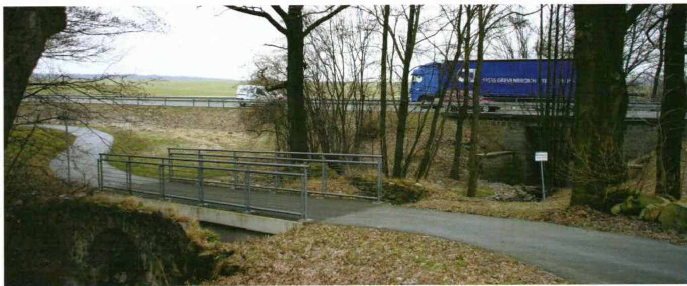
3 Mehrere Straßengenerationen der via regia treffen sich. Die alte Brücke der „Hohen Straße“, die sogenannte Napoleonbrücke, östlich Reichenbach trägt inzwischen einen Radweg, die Bundesstraße verläuft hier schon jahrzehntelang wenige Meter südlich. Frühjahr 2011
